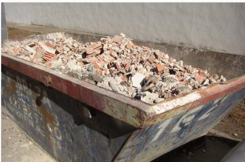
Figura nº8. Contenedor con residuos de construcción y demolición
